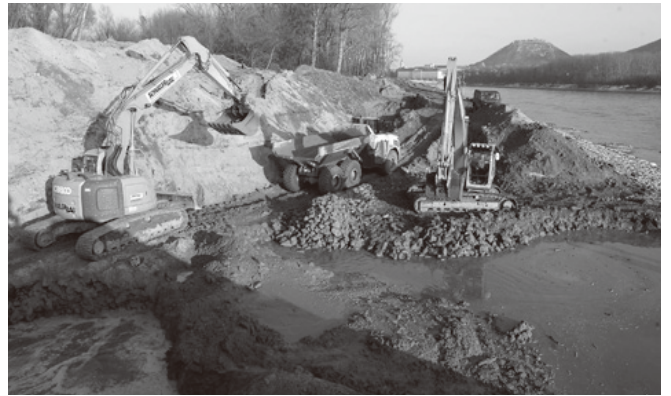
ドナウ川下流(ウィーン)での、護岸の撤去工事。 Photo by Alexander Zinke
