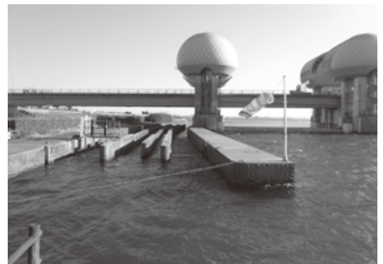
長良川河口堰右岸の「せせらぎ魚道」(上)と、右岸と左岸にある「呼び水式魚道」(下)。 Photo by Alexander Zinke
