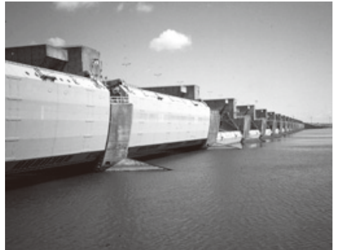
ハーリングフリート河口堰。 Photo by 保屋野初子
