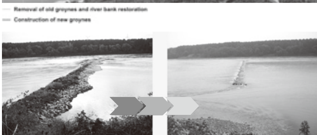
生態系の改善のため水制を縮小するが、船の航行には影響が出ないだけでなく、むしろ改善された。上の写真が示すように、水深は変わらず、水制の角度を変えて水が下流に流れやすくなった。それによって水制の数を減らし高さも下げることができた。さらに水制と護岸との淵に水路を作り、魚が川岸に沿って遡上出来るようにした。下の写真の左が工事前、右は工事後。 Photo by via donau
