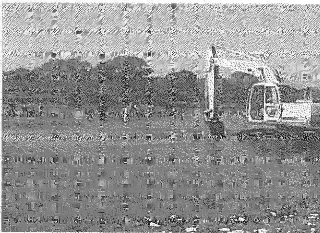
かさざぎ大橋上(懸田市寺谷地先)アユ産卵場造成風景
