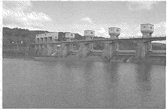
明治用水頭首工
