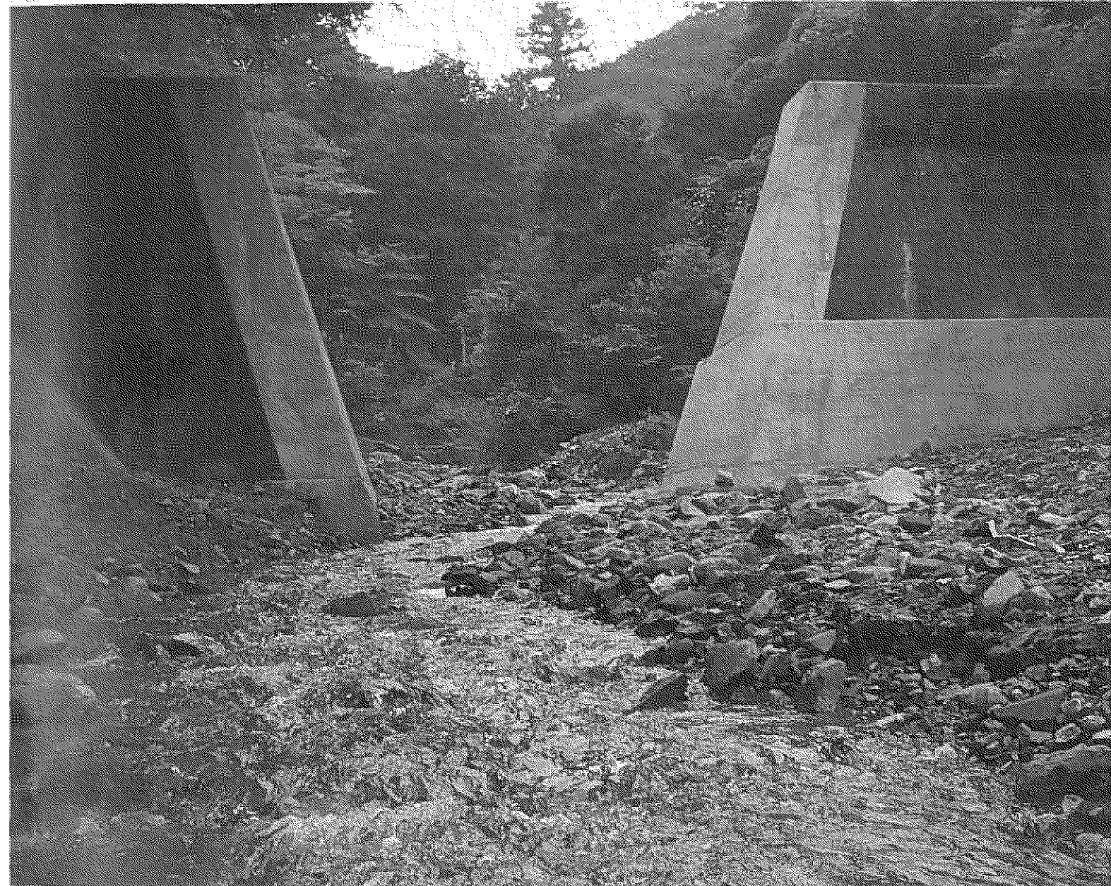
赤谷プロジェクトにおいて第1段階として中央部が除去された資者沢2号ダム。モニタリング後に第2段階として両端部の壁も視野に入れられている。Photo by 藤田 純克
