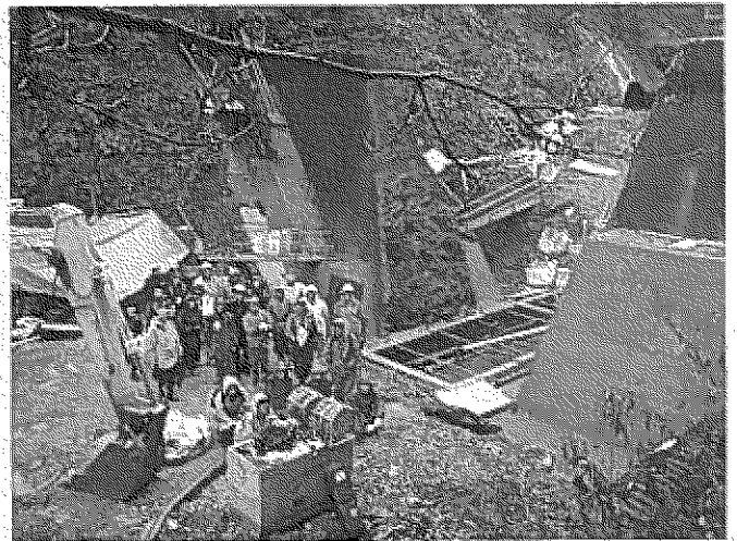
撤去工事中の2号ダムで集合写真(2009.11.2撮影)
