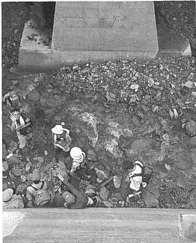
2号ダムの開口部を上から撮影(2010.8.1撮影)
