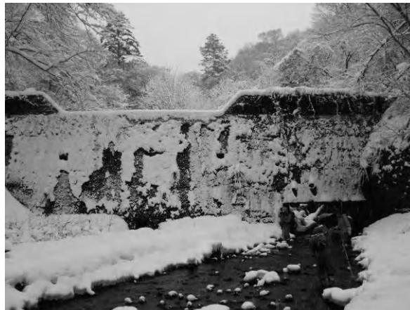
赤谷プロジェクトにて撤去が決定した茂倉沢2号堰堤
