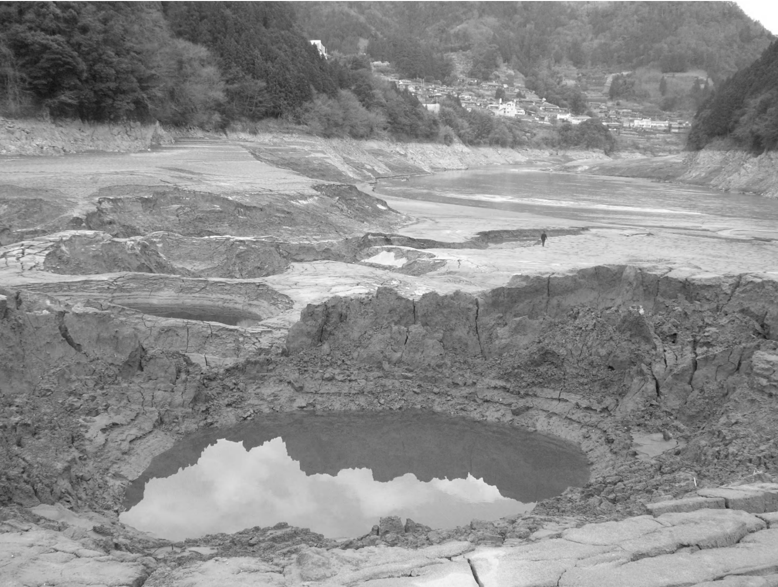
大量の堆砂で埋まる天竜川・佐久間ダムの貯水池上流。巨大な穴は、ポンプ式浚渫船による堆砂土移送の採取跡。 Photo by 豊田 崇文
