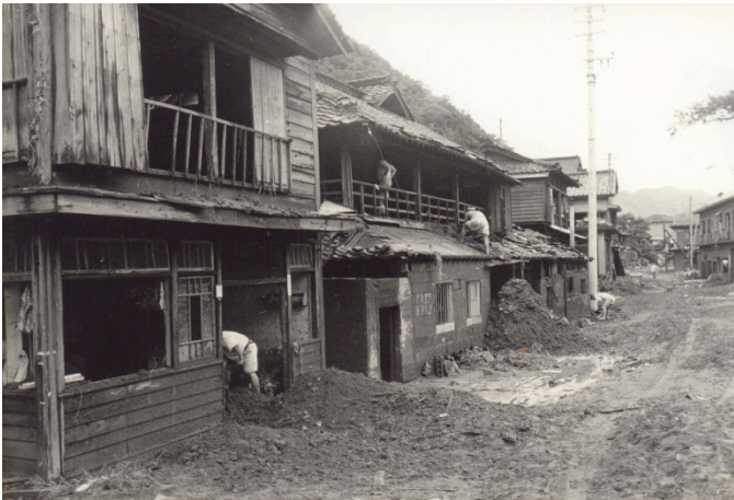
昭和40年7月の大水害：過去の洪水と違い、水位の上昇が早く、大量の土砂が家まで流れ込んだ。
